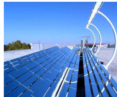
FIGURE 6.19. Une unité de cogénération photovoltaïque (chaleur et électricité) fabriquée par Heliodynamics. Un réflecteur couvrant 32 m 2 (un peu plus grand que le côté d'un bus à deux étages) fournit jusqu'à 10 kW de chaleur et 1,5 kW de puissance électrique. Dans le sud des États-Unis, un de ces dispositifs d'une tonne pourrait fournir de l'ordre de 60 kWh/j de chaleur et de 9 kWh/j d'électricité. Ces puissances correspondent à des flux moyens de 80 W/m 2 de chaleur et 12 W/m 2 d'électricité (par mètre carré de surface photovoltaïque cogénératrice); ces flux sont similaires à ceux fournis par des panneaux solaires thermiques et photovoltaïques standards, mais la conception de concentration de Heliodynamics fournit cette puissance à moindre coût, parce que l'essentiel du matériau utilisé est une vitre plate toute simple. A titre de comparaison, la consommation totale de puissance d'un Européen moyen est de 125 kWh/j.
