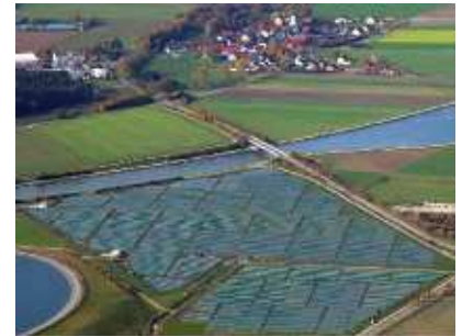
FIGURE 6.7. Une ferme solaire photovoltaïque : le Solarpark de 6,3 MW (en crête) à Mühlhausen, en Bavière. On s'attend à ce que sa puissance moyenne par unité de surface soit d'environ 5 W/m 2 . Photographie fournie par SunPower.
