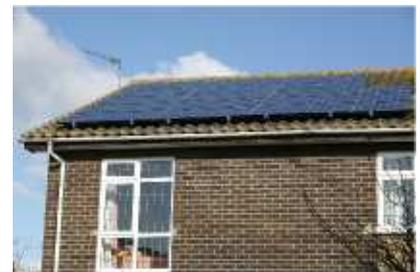
FIGURE 6.5. Le solaire photovoltaïque : les données proviennent d'un ensemble de  $25 \text{ m}^2$  de panneaux installés dans le Cambridgeshire en 2006. La puissance-crête fournie par cet ensemble est d'environ 4 kW. La puissance moyenne sur l'ensemble de l'année est de 12 kWh par jour. Ce qui fait 20 W par mètre carré de panneau.
