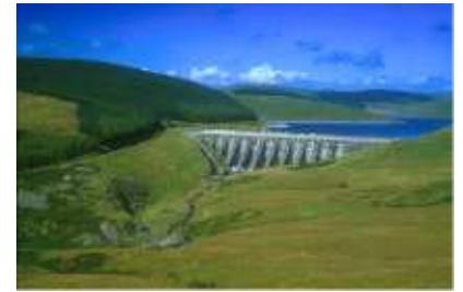
FIGURE 8.1. Barrage de Nant-y-Moch, faisant partie d'un aménagement hydroélectrique de 55 MW au Pays de Galles. Photographie de Dave Newbould, www.origins-photography.co.uk .
