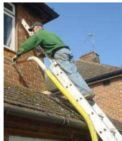
FIGURE 21.5. Insertion d'une isolation des murs creux.
