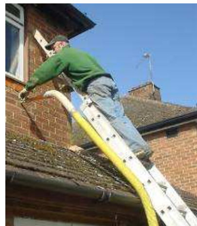
FIGURE 21.5. Insertion d'une isolation des murs creux.
