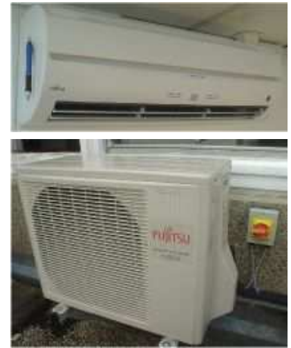
FIGURE 21.11. Les parties intérieures et extérieures d'une pompe à chaleur air-air qui a un coefficient de performance de 4. A la partie intérieure, on a joint un stylo à bille, pour l'échelle. Une seule de ces machines Fujitsu peut fournir 3,6 kW de chaleur en utilisant seulement 0,845 kW d'électricité. Elle peut également fonctionner de manière inversée, fournissant 2,6 kW de froid en consommant 0,655 kW d'électricité.
