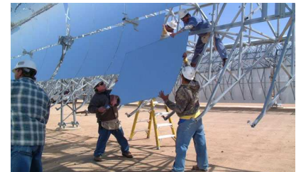
FIGURE 25.4. Andasol — une centrale solaire de « 100 MW » en construction en Espagne. L'énergie thermique en excès produite durant le jour est stockée dans des réservoirs de sels fondus pendant une durée maximum de 7 heures, permettant une fourniture stable et continue de puissance au réseau électrique. La centrale est prévue pour produire 350 GWh par an (40 MW). Les miroirs paraboliques occupent 400 hectares, et leur puissance par unité de surface sera de 10 \text{ W/m}^2 . Photo du haut : ABB. Photo du bas : IEA SolarPACES.
