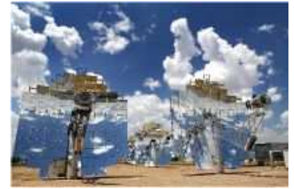
FIGURE 25.3. Moteurs Stirling à parabole. Ces magnifiques concentrateurs fournissent une puissance par unité de surface de 14 \text{ W/m}^2 . Photo gracieusement fournie par Stirling Energy Systems. www.stirlingenergy.com
