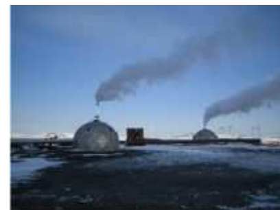
FIGURE 25.11. Plus de puissance géothermique en Islande. Photo de Rosie Ward.
