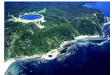
FIGURE 26.11. Centrale de pompage d'Okinawa, dont le réservoir aval est l'océan. Quantité d'énergie stockée : 0,2 GWh. Photo gracieusement fournie par J-Power. www.ieahydro.org .
