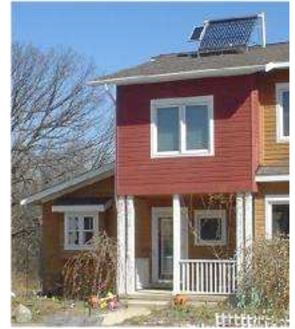
FIGURE 30.2. Un chauffe-eau solaire fournissant de l'eau chaude à une famille du Michigan. La pompe du système est alimentée par le petit panneau photovoltaïque à gauche.
