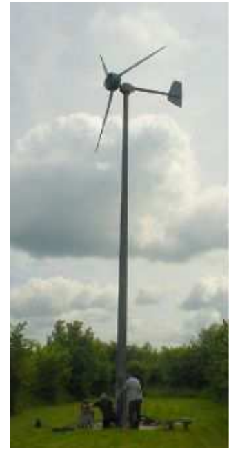
FIGURE B.10. Une turbine Iskra de 5,5 mètres de diamètre et de 5 kW de puissance [www.iskrawind.com], subissant son contrôle annuel. Cette turbine, située dans le Hertfordshire (pas vraiment la région la plus ventée de Grande-Bretagne), installée à une hauteur de 12 mètres, génère en moyenne 11 kWh par jour. Une ferme éolienne composée de machines ayant cette performance, avec une éolienne installée pour chaque carré de terrain de 30 mètres de côté, aurait une puissance par unité de surface de 0,5 W/m 2 .
