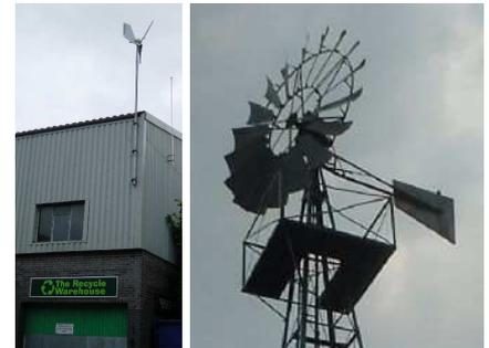
FIGURE B.9. Une micro-turbine Ampair de « 600 W ». La puissance moyenne générée par cette micro-turbine installée à Leamington Spa est de 0,037 kWh par jour (1,5 W).
