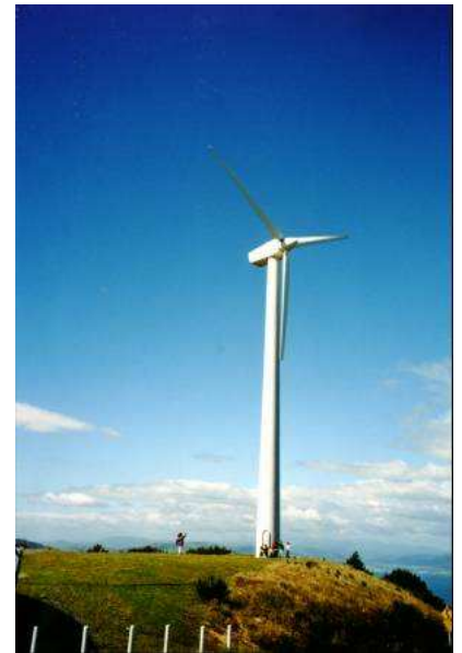
FIGURE B.3. L'éolienne de Brooklyn au dessus de Wellington, en Nouvelle-Zélande, avec quelques personnes à son pied pour donner l'échelle. Un jour de vent, cette éolienne produit 60 kW (soit 1 400 kWh par jour). Photo par Philip Banks.
