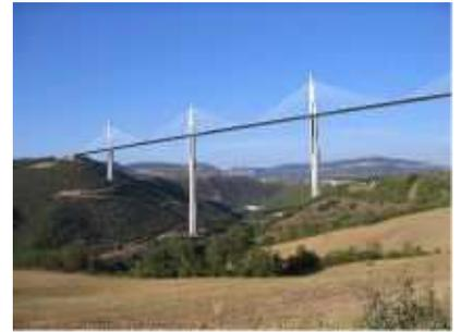
FIGURE H.7. Le viaduc de Millau, en France, le plus haut pont du monde à ce jour. Fait d'acier et de béton, long de 2,5 km et haut de 353 m.
