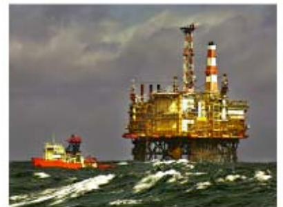
Photo : Terry Cavern
