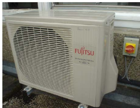
Figure 13. Bon: les parties internes et externes d'une pompe à chaleur air/air dont le coefficient de performance est 4. Le stylobille sur la partie interne est là pour montrer l'échelle. Une de ces unités Fujitsu peut fournir 3,6 kW de chauffage en utilisant seulement 0,845 kW d'électricité. Elle peut aussi fonctionner en mode réversible, fournissant 2,6 kW de refroidissement en consommant 0,655 kW d'électricité.
